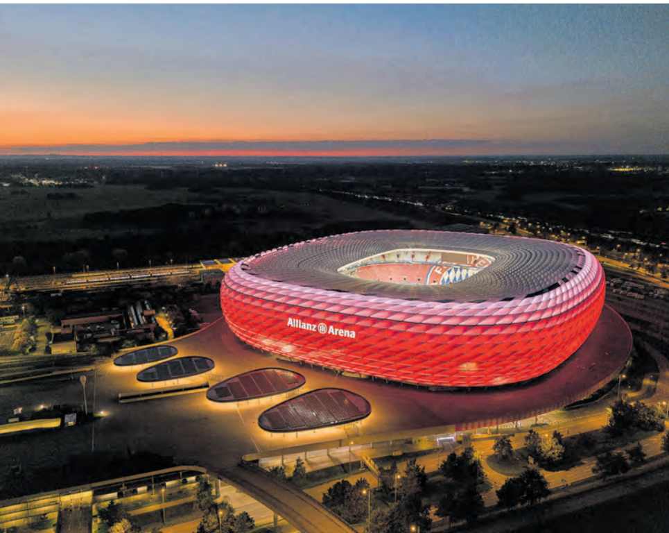
Die Beleuchtung der Münchner Allianz Arena fasziniert immer wieder. Die Folienkissen ihrer Fassade stammen von einer Firma am Chiemsee. Foto: Allianz Arena / B. Dücke
