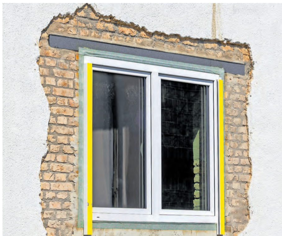
DER EINBAU NEUER FENSTER GEHÖRT BEI EINER KERNSANIERUNG DAZU UND KANN STAATLICH GEFÖRDERT WERDEN.
