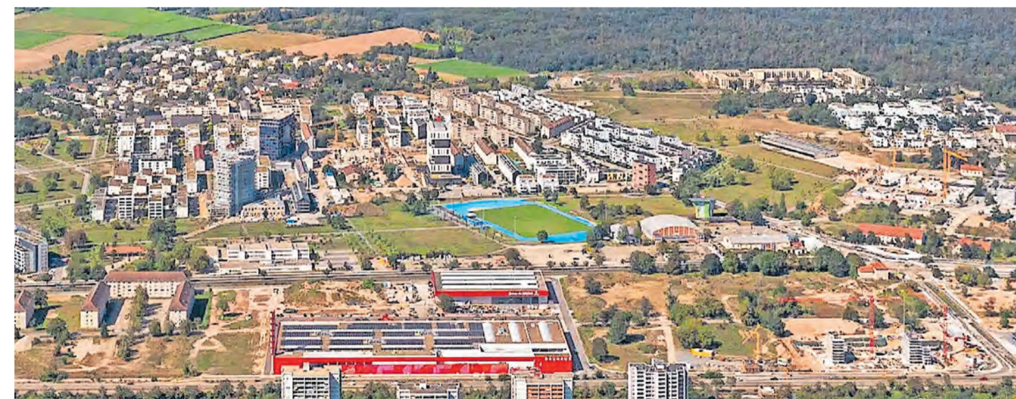
Die aktuell wohl größte Baustelle Deutschlands nimmt allmählich Gestalt an. Das Bild zeigt das Projektgebiet Franklin. FOTO: MWSP/DROHNEN-LUFTBILDER360
