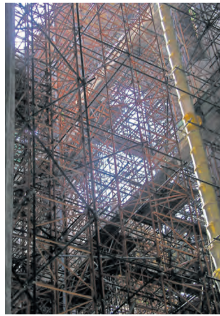
HOHE GERÜSTBAUTEN WAREN ZUM INNENAUSBAU DER KATHEDRALE NOTWENDIG. FOTO: PIXABAY
