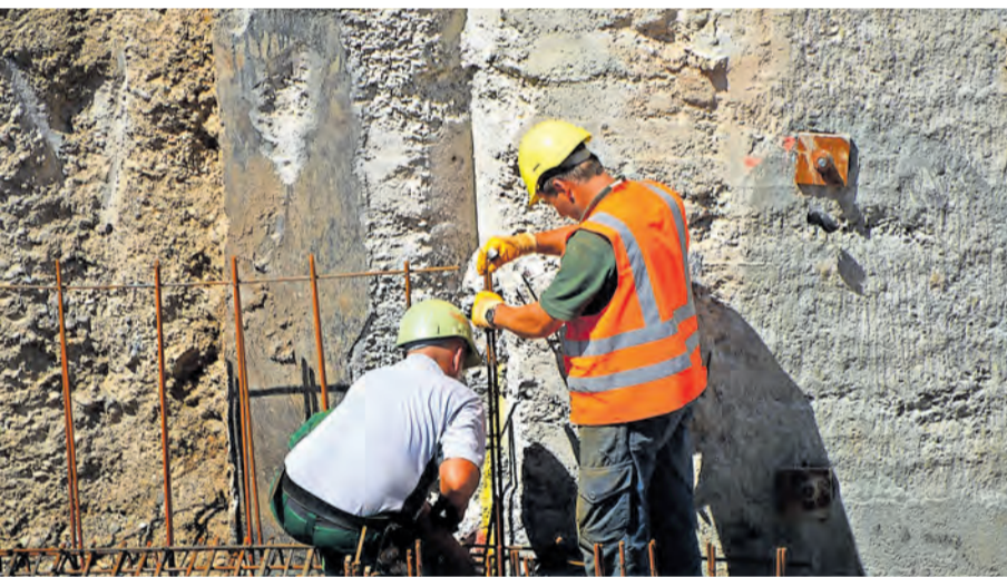
BAUARBEIT FINDET NICHT SELTEN BEI SENGENDER HITZE UND ERHÖHTEN OZONWERTEN STATT. HANDWERKER WIE MATERIAL MÜSSEN DAVOR GESCHÜTZT WERDEN.
