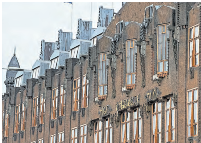
FÜR DIE FASSADE DES SCHEEPVAARTHUIS WURDEN VERSCHIEDENE ZIEGELARTEN UND ZAHLREICHE DEKORATIVE ELEMENTE VERWENDET. FOTO: W. SEIPP
