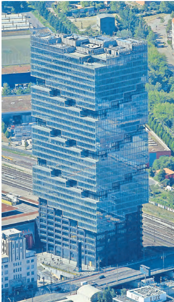
DAS GESTALTUNGSPRINZIP DES DÄNISCHEN ARCHITEKTEN BJARKE INGELS MIT DER AUFLÖSUNG DER KUBEN IN EINZELNE, GEGENEINANDER GESTAFFELTE SEGMENTE BRINGT BEWEGUNG IN DIE FASSADE.
