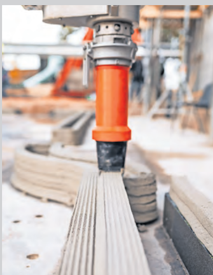
BAUEN MITTELS 3D-DRUCKER IM DETAIL. FOTO: HOFFMANN-KORTE
