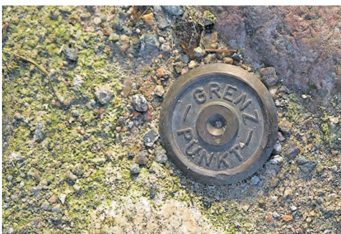
MODERNE GRENZPUNKTE SIND EHER UNSCHENBAR, KÖNNEN SCHON MAL SCHNELL VERSCHÜTTET ODER AUS VERSEHEN ENTFERNT WERDEN.
