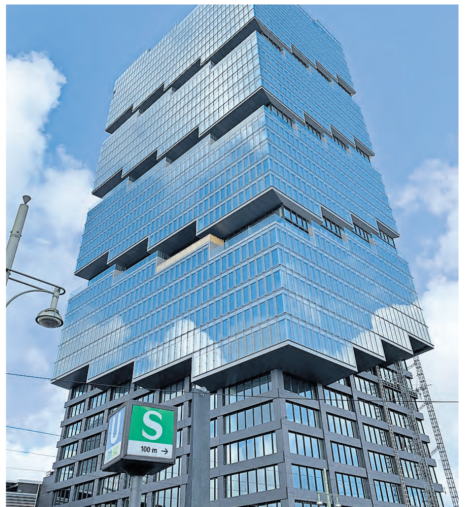
DIE OPTISCHE VERLAGERUNG DER MASSE NACH OBEN NIMMT DEM BAU DIE MASSIGE SCHWERE, BEWAHRT ABER DIE WUCHTIGE ERSCHENUNG. FOTO: WIKIMEDIA/CHAINWIT.
