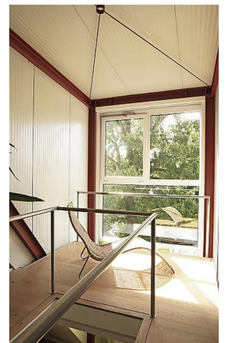
DIE STAHLKONSTRUKTION DES GAUBENARTIGEN VORBAUS BLIEB INNEN UNVERKLEIDET.
