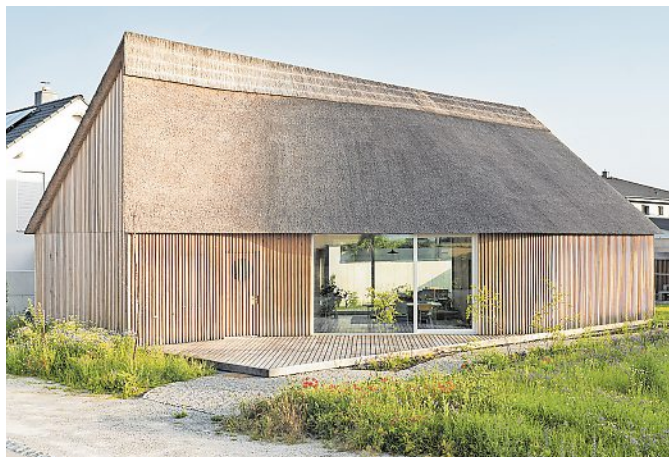
EIN SCHILFDACH IN MODERNEM KONTEXT ZEIGT DAS NEWCOMER PROJEKT VON ARCHITEKT GILBERT BERTHOLD. FOTO: ARNAUD BOSTELMANN
