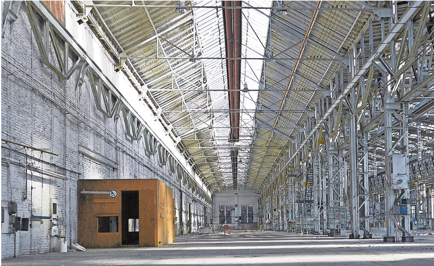
BLICK IN DIE UNSANIERTER HALLE IN KÖLN-KALK, IN DER FRÜHER MOTOREN GEBAUT WURDEN.
