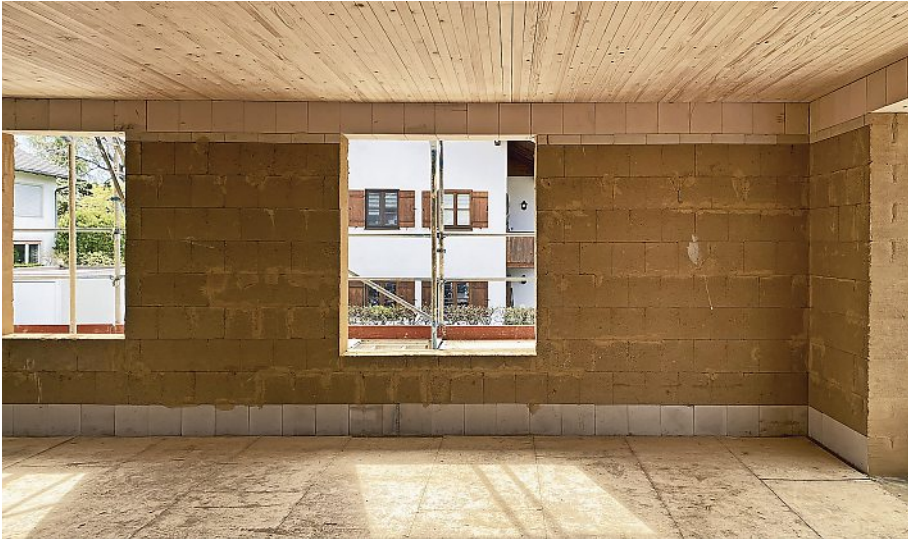
FÜR DIESEN BAU WURDEN LASTTRAGENDE LEHMSTEINE VERWENDET. FOTO: SIMON FLÖRKE
