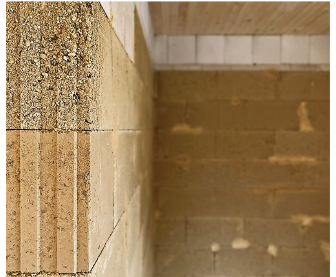
LEHMZIEGEL GIBT ES INDUSTRIELL GEFERTIGT NACH DIN-NORM.
