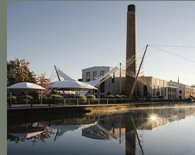
Mangfallkanal mit Turbinenhaus und Seilnetz
