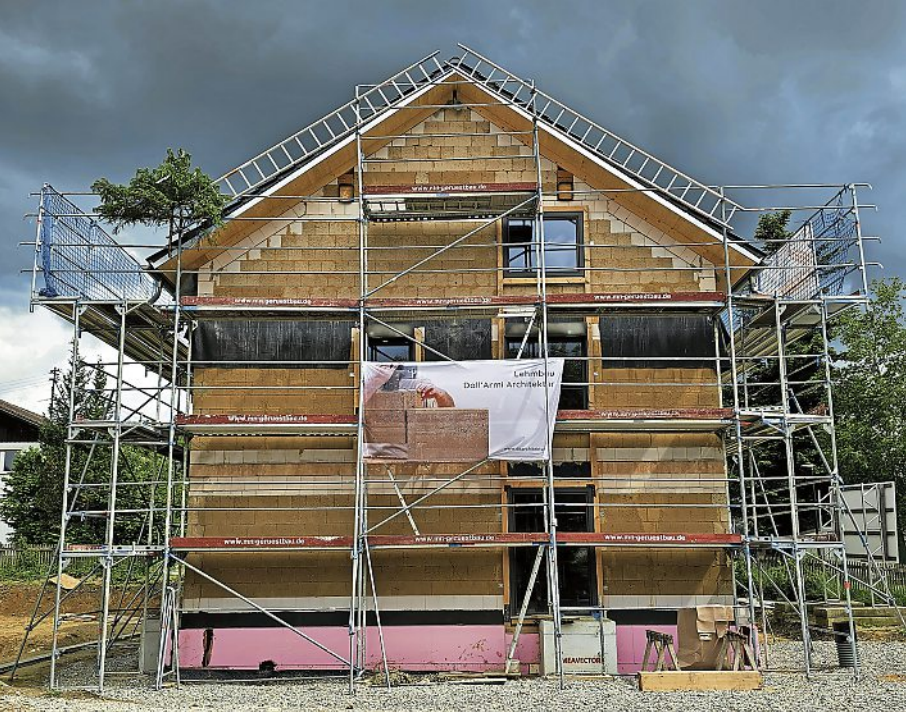
IN LEHMBAUWEISE ERRICHTETES DOPPELHAUS.
