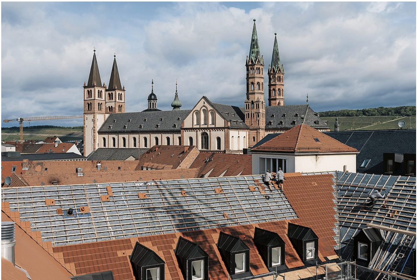
AUF DEM DACH DES KONGREGATIONSHAUSES DER WÜRZBURGER ERLÖSCHWESTERN WURDEN 20.000 SOLARZIEGEL VERLEGT.
