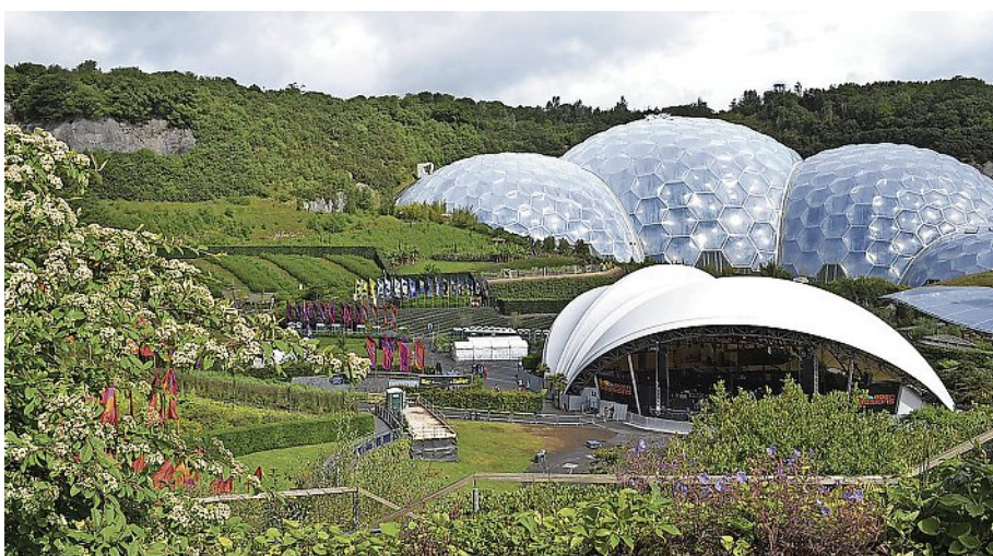
DIE GEODÄTISCHEN KUPPEL DES BOTANISCHEN GARTENS IN CORNWALL BENÖTIGEN DANK RAFFINierter MATERIALIEN KEINE AUFWENDIGE TRAGEKONSTRUKTION. FOTO: PIXABAY/PENSTONES
