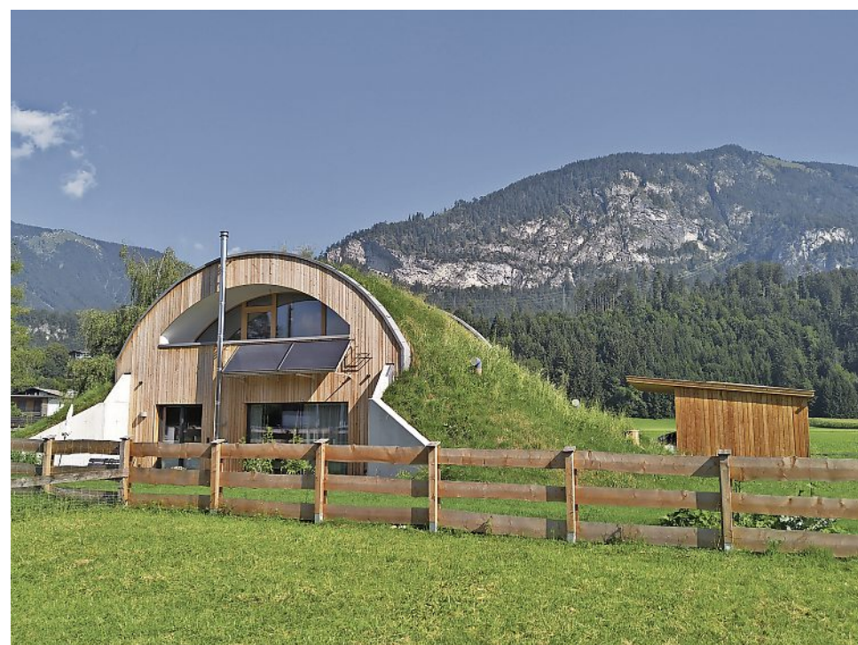
LICHT UND SONNE SIND AUCH BEI ERDHÜGELHÄUSERN FÜR DIE POSITIVE ENERGIEBILANZ ESSENZIELL
