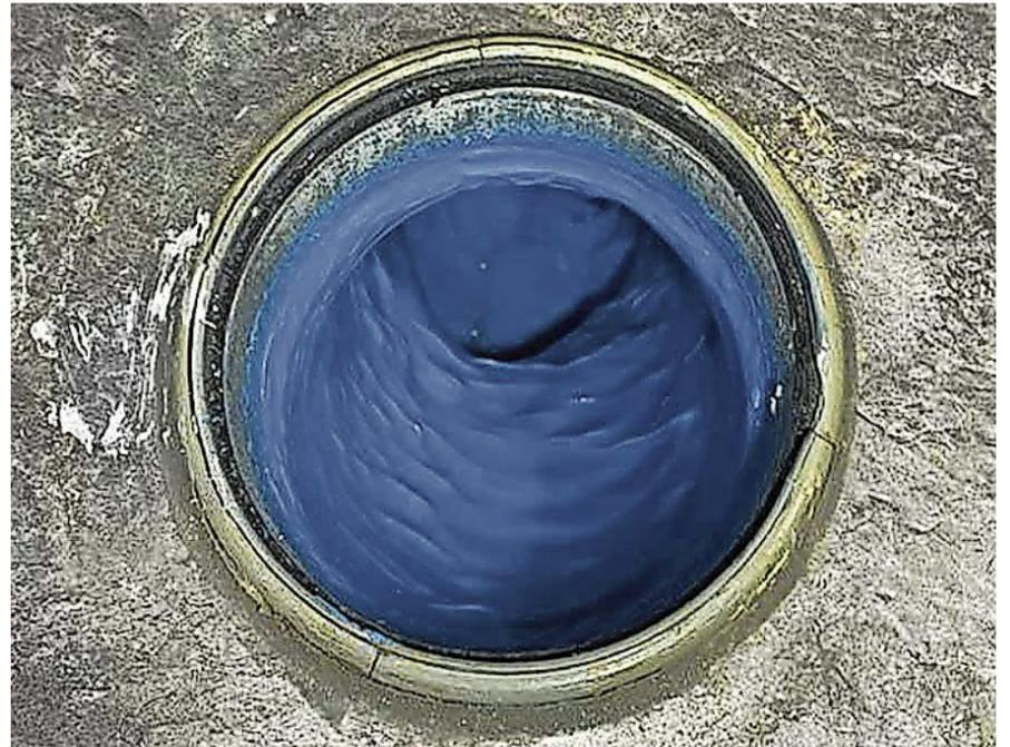
EIN IN DIE JAHRE GEKOMMENES ROHR, STARK VON KORROSION ANGEGRIFFEN, WEIST NACH DER REINIGUNG KEINE EBENE OBERFLÄCHE AUF. BEIM SPRAY-COATING WIRD TROTZDEM EINE ÜBERALL FAST GLEICHE SCHICHT AUFGETRAGEN, SODASS EINE WASSERDICHTHE ROHR-IN-ROHR-LEITUNG ENTSTEHT FOTO: ROTEK ROHRREINIGUNGSDIENST
