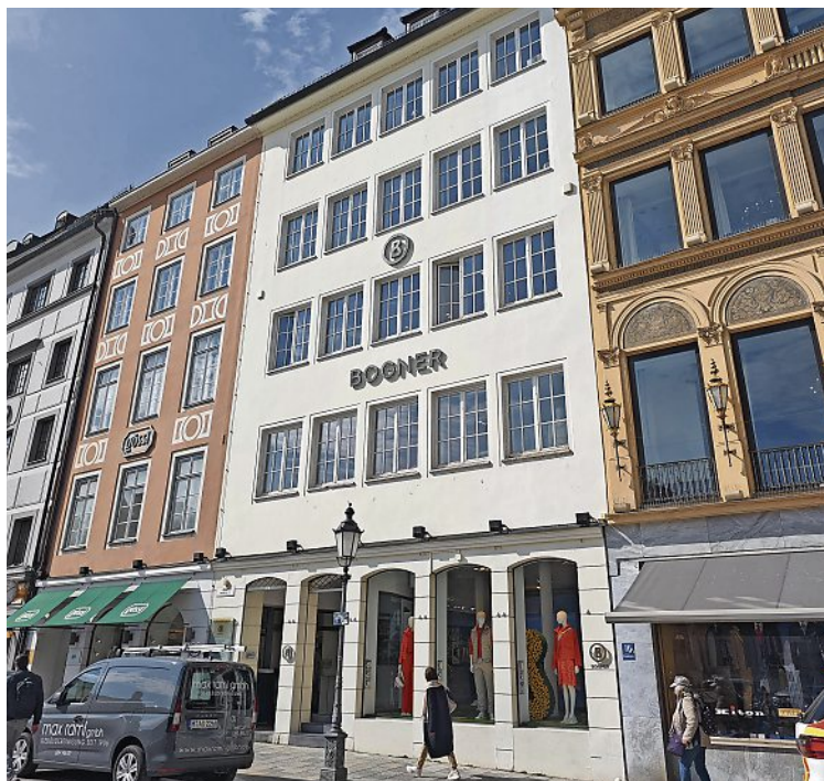
DAS SOGENANnte BOGNER-HAUS IN DER RESIDENZSTRASSE WURDE ANFANG DER 1960ER-JAHRE ERBAUT UND STEHT NUN AUFGRUND GROSSER BAULICHER MÄNGEL VOR DEM ABRISS. FOTO: KELLY KELCH
