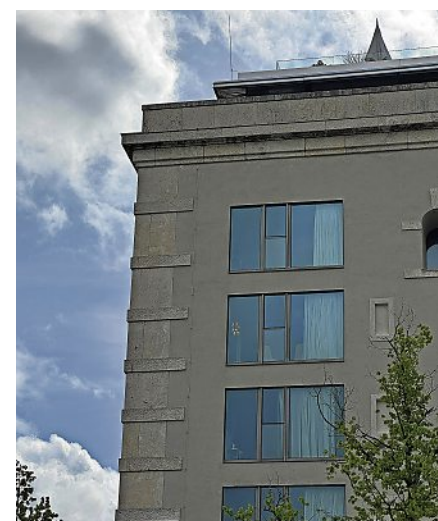
LICHT IN BUNKER ZU BRINGEN, ERFORDERT BEI METERDICKEN WÄNDEN SCHWERSTARBEIT UND DIAMANTSÄGEN. DIE FENSTER BEIM BUNKER IN DER UNGERERSTRASSE WURDEN AUSSEN ANGESETZT, UM DEN PLATZ INNEN ZU NUTZEN. FOTO: W. SEIPP
