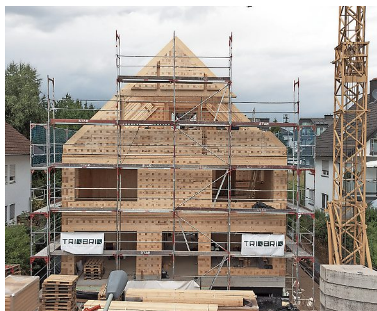
EINE ROHBAU-FASSADE MIT „BRIQS“ BEI EINEM MEHRFAMILIENHAUS IN FRANKFURT. FOTO: TRIQBRIQ
