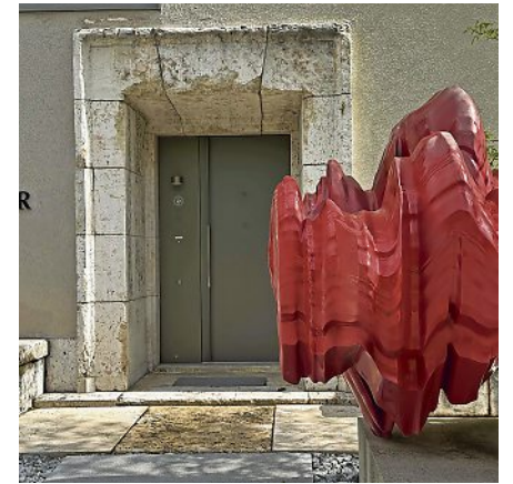
BEIM EINGANG ZUM BUNKER IN DER UNGERERSTRASSE WERDEN DIE MASSIVEN, ZWEI METER DICKEN AUSSENWÄNDE DEUTLICH. FOTO: W. SEIPP
