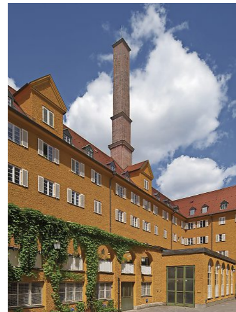
DAS ZENTRALE HEIZWERK DER BORSTEI IST DAS ERSTE SEINER ART IN DEUTSCHLAND. ES SPEIST DIE ZENTRALHEIZUNGSANLAGE SOWIE DEN WARMWASSERKREISLAUF. FOTO: WIKIMEDIA / JAN CZECZOTKA
