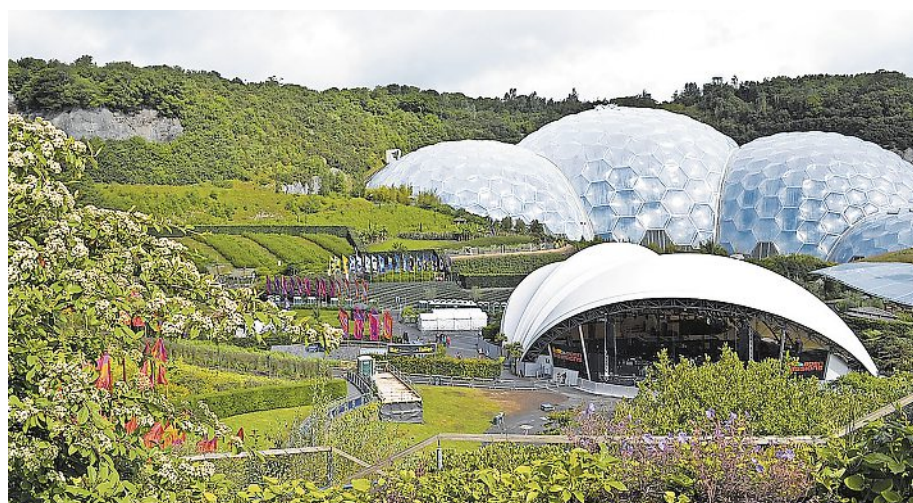
DIE GEODÄTISCHEN KUPPELLEN DES BOTANISCHEN GARTENS IN CORNWALL BENÖTIGEN DANK RAFFINIERTER MATERIALIEN KEINE AUFWENDIGE TRAGEKONSTRUKTION. FOTO: PIXABAY/PENSTONES
