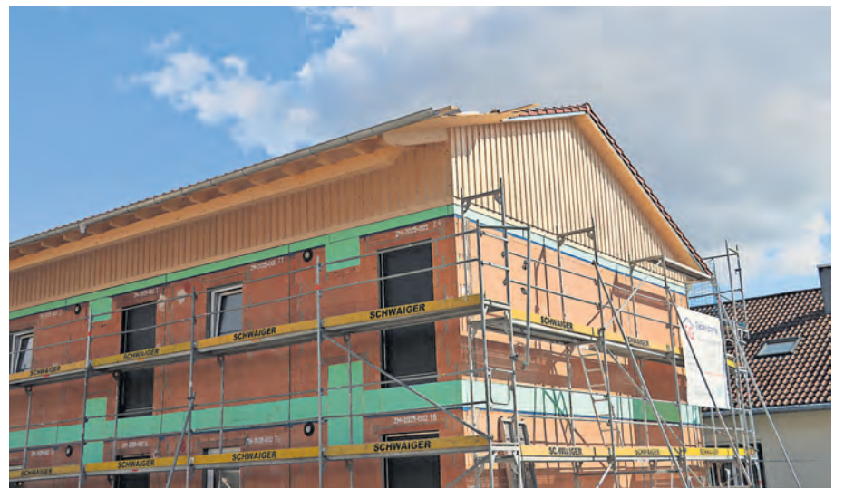
DER MODULBAU IST NICHT VON KONVENTIONELLER BAUWEISE UNTERSCHIEDBAR.
