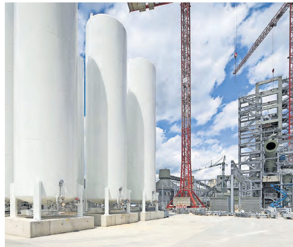
MIT DEM SOGENANTEN PURE-OXYFUEL-VERFAHREN WIE HIER AM HEIDELBERG-MATERIALS-STANDORT IN MERGESTETTEN WIRD EIN GROSSTEIL DES CO 2 ABGESCHIEDEN. FOTO: CONN, VAN DÍ GRACHTEN
