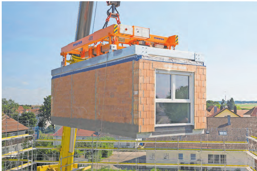
HIER „SCHWEBT“ EIN VORGEFERTIGTES ZIEGELMODUL AUF DIE BAUSTELLE.
