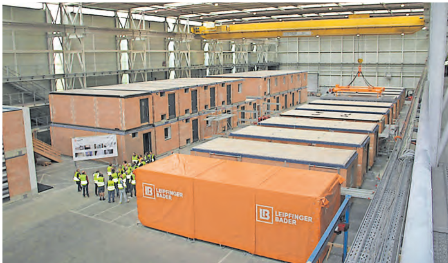
IM WERK IN PFEFFENHAUSEN WERDEN DIE MODULE VORGEFERTIGT. DIE ANLIEFERUNG DER MODULE ERFOLGT PER LKW.
