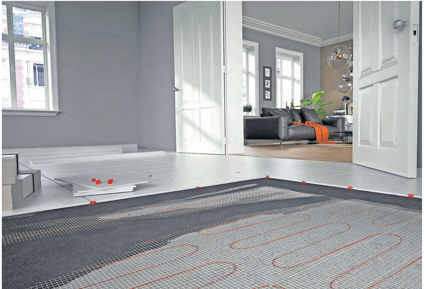
DIE GERINGE AUFBAUHÖHE IST EIN VORTEIL DER ELEKTRISCHEN FUSSBODENHEIZUNG. FOTO: VIESSMANN CLIMATE SOLUTIONS
