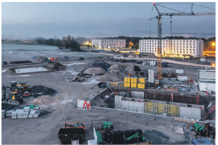
Die Erschließungsarbeiten im Quartier am Kreuzstein sind mittlerweile sichtbar. Nun soll mit den Hoch- und Tiefbauarbeiten begonnen werden.
