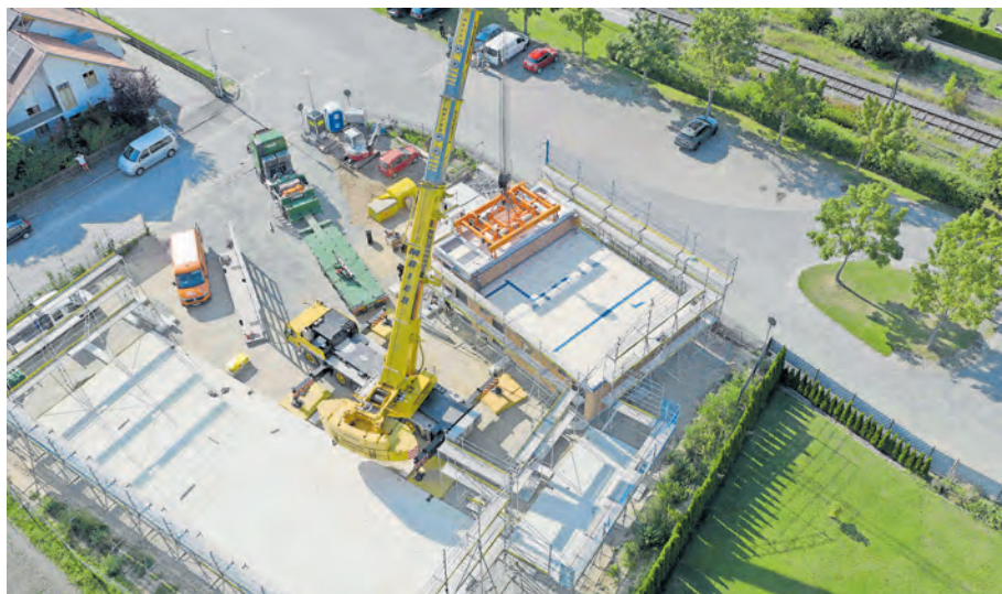
BLICK VON OBEN AUF DAS BAUPROJEKT IN LABERWEINTING.
