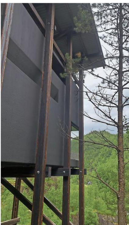
DIE AUSSENWÄNDE DER GEBÄUDE BESTEHEN AUS SPERRHOLZPLATTEN, BESCHICHTET MIT EINEM DEUTSCHEN ACRYLMATERIAL NAMED POLYMETHYLACRYLAT (PMMA).
