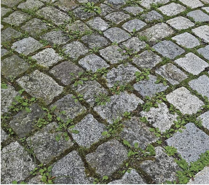
EINE UNVERFUGTE ZUFAHRT HAT DEN VORTEIL, DASS BEI STARKREGEN KEINE STURZBÄCHE ENTSTEHEN,
