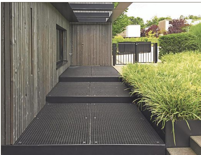
GITTERROSTE ÜBER DER ENTWÄSSERUNGSEBENE KÖNNEN SITUATIVE LÖSUNGEN SEIN. FOTO: CHRISTIANE VON BURKERSRODA
