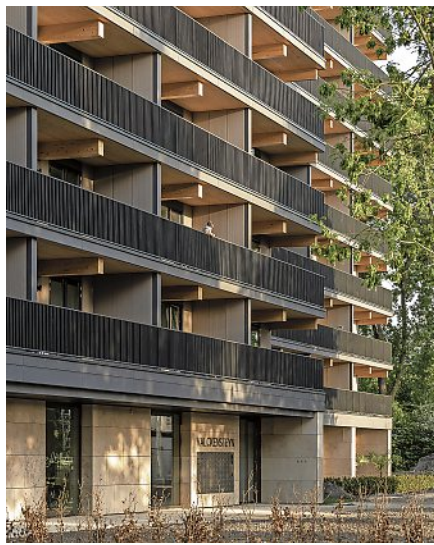
DIE LEICHTE HOLZKONSTRUKTION NUTZT NACHHALTIG DIE FUNDAMENTE DES VORGÄNGERGBÄUDES.
