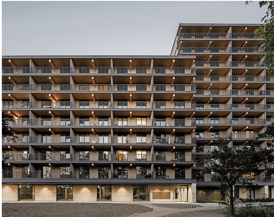
DIE GESAMTE KONSTRUKTION DES VALCKENSTEYN BESTEHT, ABGESEHEN VOM ERDGESCHOSS UND DEN KERNEN, AUS BRETTSPERRHOLZ (CLT). ALLE FOTOS: POWERHOUSE COMPANY / SEBASTIAN VAN DAMME
