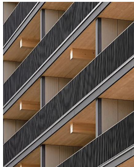
FREILIEGENDE BRETTSCHICHTHOLZBALKEN PRÄGEN DIE ARCHITEKTONISCHE GESTALTUNG.
