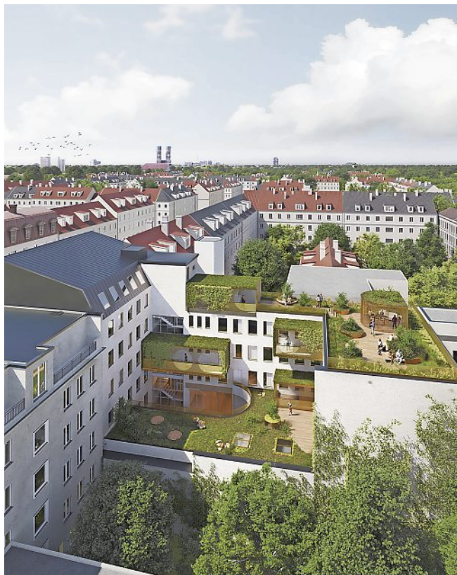
NOCH LÄSST SICH DER WEITE BLICK VON DER DACHTERRASSE DES NETZWERKHAUSES LANDN NICHT GENIEßEN, DAS ÄNDERT SICH MIT FERTIGSTELLUNG VORAUSSICHTLICH ENDE 2026.
