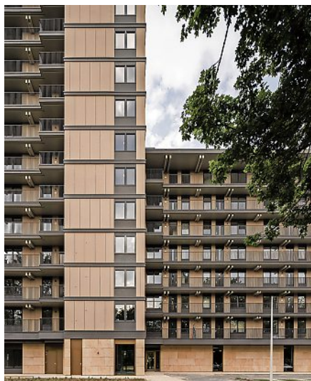
GANZ OHNE KLEBSTOFFE ERRICHTET, IST DAS GEBÄUDE ZUKUNFTSFÄHIG GEDACHT UND VOLLSTÄNDIG DEMONTIERBAR.
