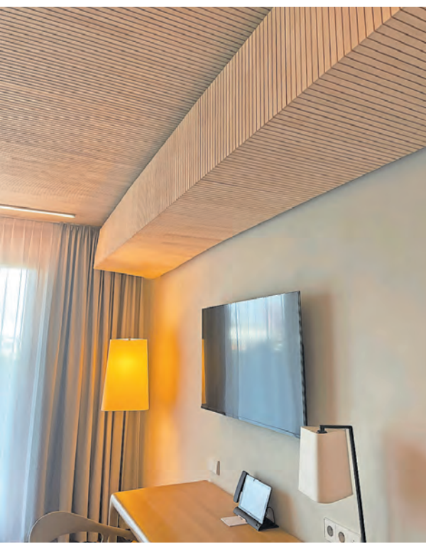
IN DEN ZIMMERN WURDE DIE TECHNIK GESCHICKT HINTER HOLZLAMELLEN „VERSTECKT“. FOTO: B. BRUBACHER
