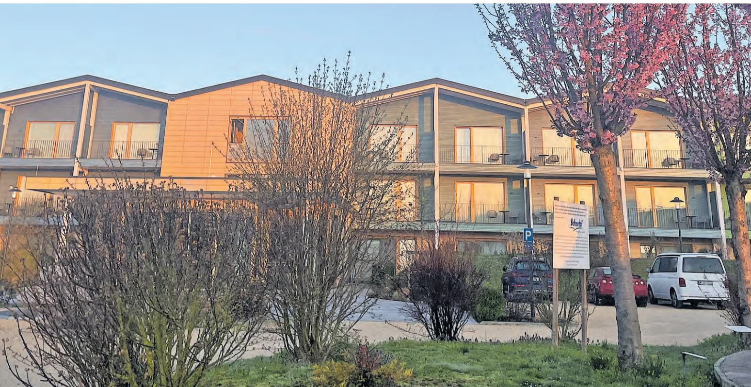
DAS LANDHOTEL BOHRERHOF IST EIN MUSTERBEISPIEL FÜR NACHHALTIGEN HOTELBAU. FOTO: B. BRUBACHER
