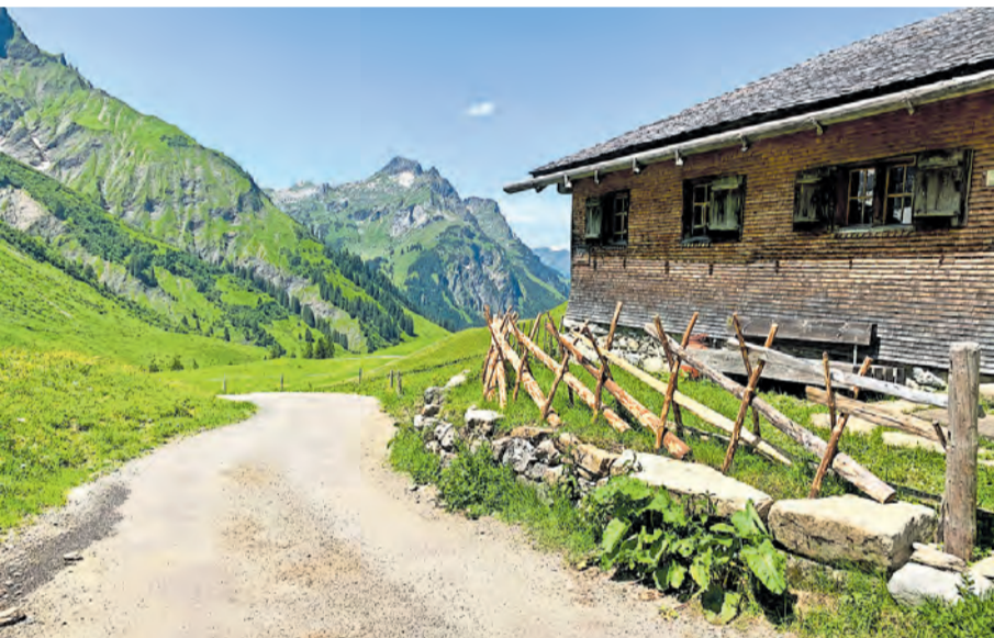
AUF DEM WEG VON SCHRÖCKEN ZUM KÖRBERSEE LIEGT DIE ALTE SENNALPE BATZEN, DEREN ÄLTESTE BALKEN 1602 GESCHLAGEN WURDEN. DIE BIS 1998 BEWIRTSCHAFTETE ALPE DIENT HEUTE ALS MUSEUM. FOTO: F. HORN
