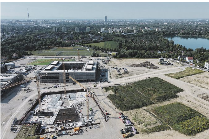
Die Bauarbeiten laufen: Nach der Grundsteinlegung folgt als nächster Meilenstein das Richtfest.
