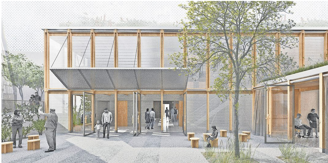
EINE NEUE KLIMAHÜLLE AUS GLAS LEGT SICH UM DEN ERHALTENEN BESTAND DES GEMEINDEHAUSES FEUERBACH.
