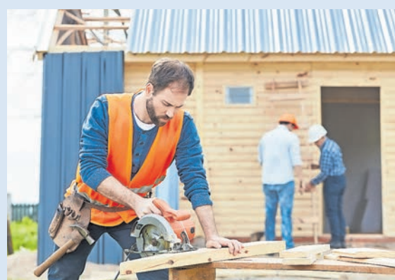
Häuser aus dem nachwachsenden Rohstoff Holz werden immer beliebter. Daher haben Zimmerer gut zu tun. Foto: Adobestock
