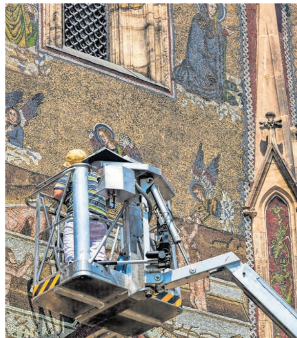
Kirchenmaler arbeiten auch in luftiger Höhe, nur so können sie diffizile Restaurierungen fachgerecht ausführen.
