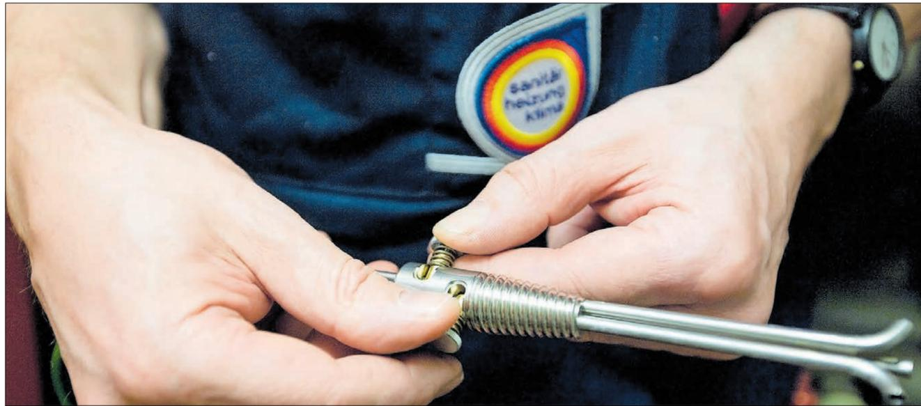
Alte Heizsysteme verlieren unnötig viel Wärme über den Schornstein. Mit einer Sonde können Heizungsfachleute die Ventilationsverluste messen – diese Arbeit ist Teil des Heizungschecks. Foto: BVHSK
