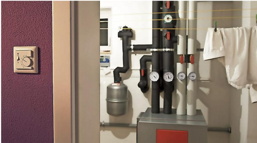
EINE WÄRMEPUMPE KANN PLATZSPAREND IM HEIZUNGSKELLER INTEGRIERT WERDEN.
