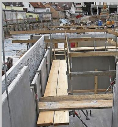
HOHLWÄNDE LASSEN SICH VORFERTIGEN UND FÜR DEN KONKRETEN EINSATZ AN DER BAUSTELLE MIT EINBAUTEN UND INSTALLATIONEN AUSSTATTEN. ZUR WEITERVERARBEITUNG MÜSSEN SIE NOCH NICHT EINMAL VERPUTZT WERDEN.
