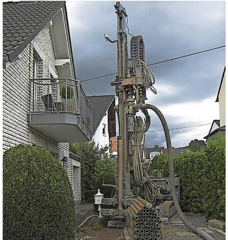
FÜR EINE ERDSONDE MUSS MIT SCHWEREM GERÄT GEBOHRTWERDEN.
