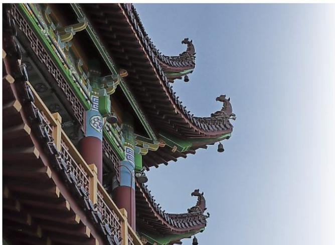
DER KAISERPALAST VON BEIJING (PEKING) ÜBERDAUERTE TROTZ ERDBEBEN JAHRTAUSENDE. ZU VERDANKEN HAT ER DAS VERBINDUNGEN ZWISCHEN STÜTZEN UND GEBÄLK, DIE AUS INEINANDER GESTECKTEN HÖLZERN BESTEHEN. DAS TEKTONISCH FLEXIBLE SYSTEM WURDE IN DEN REICHEREN BAUWERKEN ALS VERZIERUNG AUSGESTALTET UND IST MIT SEINER FORMENVIELFALT TYPISCH FÜR DIE CHINESISCHE ARCHITEKTUR.
