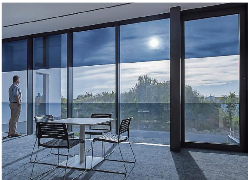
IST DER SONNENSCHUTZ IM GLAS BEREITS INTEGRIERT, WERDEN EXTERNE BESCHATTUNGSELEMENTE OBSOLET. INTELLIGENZ BEWEIST DER WERKSTOFF ÜBERDIES, WENN ER SICH SELBSTSTÄNDIG BEIM EINFALLENDEN SONNENLICHT VERDUNKELT. FOTO: SAGE-GLASS
