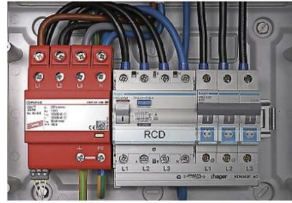
spannungsgeräte, die Endgeräte von Überspannungsimpulsen abschirmen. Sie werden darin stufenweise auf ein verträgliches Maß reduziert. Doch hier sind Fachleute gefragt, denn nur die richtige Abstimmung der Überspannungsschutz-
